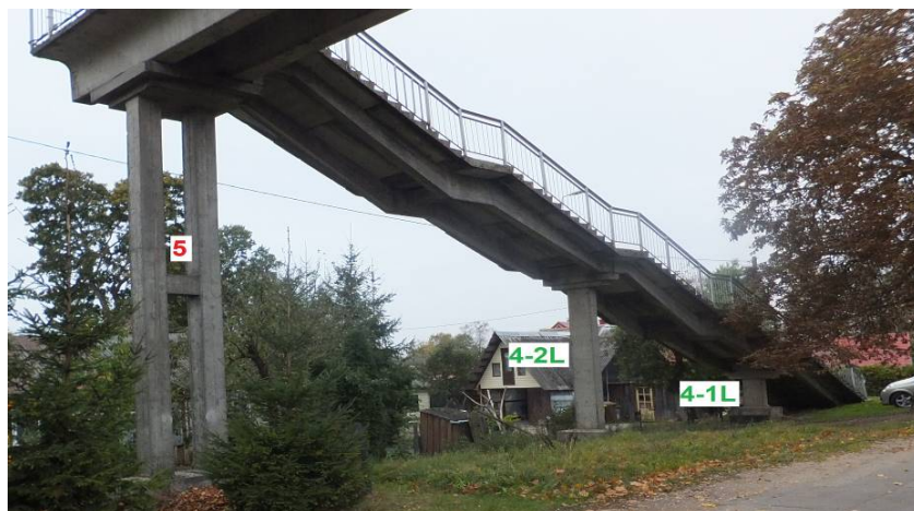
5. pav. Penkta viaduko atrama ir ketvirtieji laiptai
