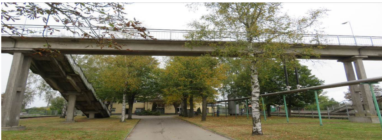
2.35 pav. Trečiojo tarpatramio perdangos bendras vaizdas. Perdangos ilgis – 22,0 m
