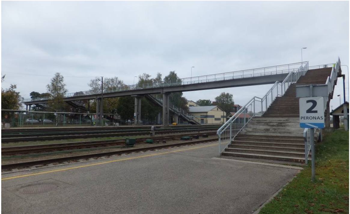
1.1 pav. Viaduko bendras vaizdas, žiūrint nuo Vilniaus pusės
