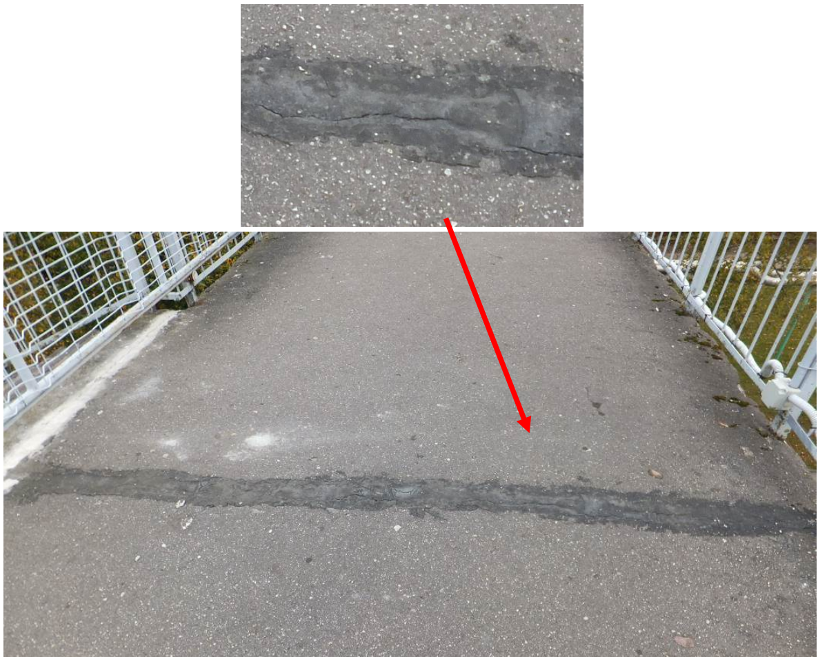
2.5. pav. Deformacinis pjūvis virš 4 atramos užglaištytas bitumine mastika, tačiau supleišėjęs ir nesandarus
