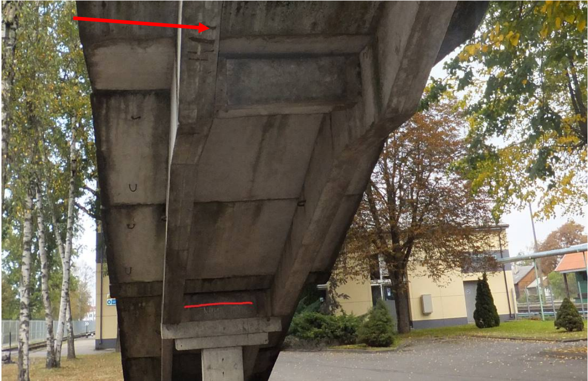
2.19. pav. Trečių laiptų laiptasijos ir atramos 3-1L rygelis supleišėję dėl armatūros korozijos
