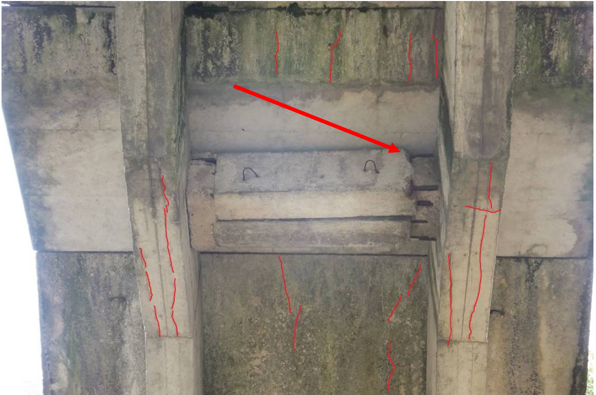
2.18. pav. Trečių laiptų laiptasijos ir maršų plokštės supleišėjusios. Korozijos pažeista laiptasijas jungiančios skersinės sijos armatūra
