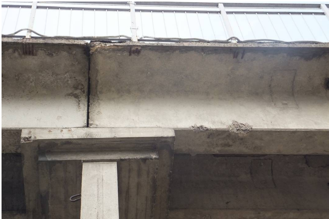
2.8. pav. Trečio tarpatramio perdangos sijos 3V briaunos mechaninis pažeidimas ties ketvirta atrama
