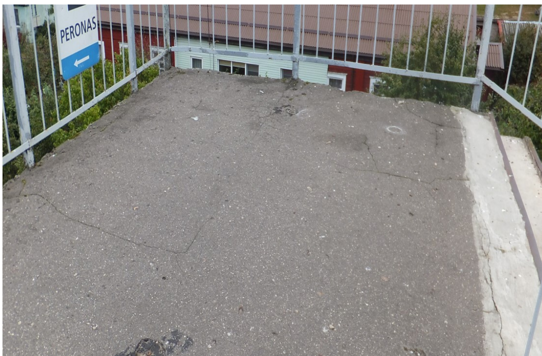
2.2. pav. Supleišėjusi asfalto danga virš pirmos atramos
