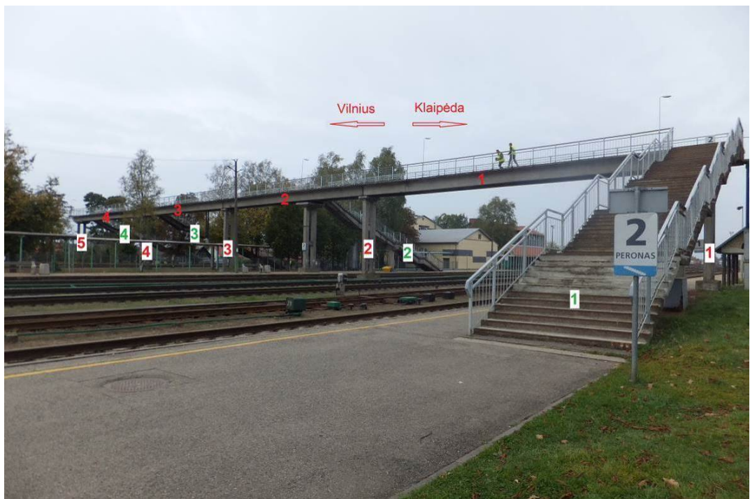
1. pav. Viaduko bendras vaizdas, žiūrint nuo Vilniaus pusės, elementų žymėjimas
