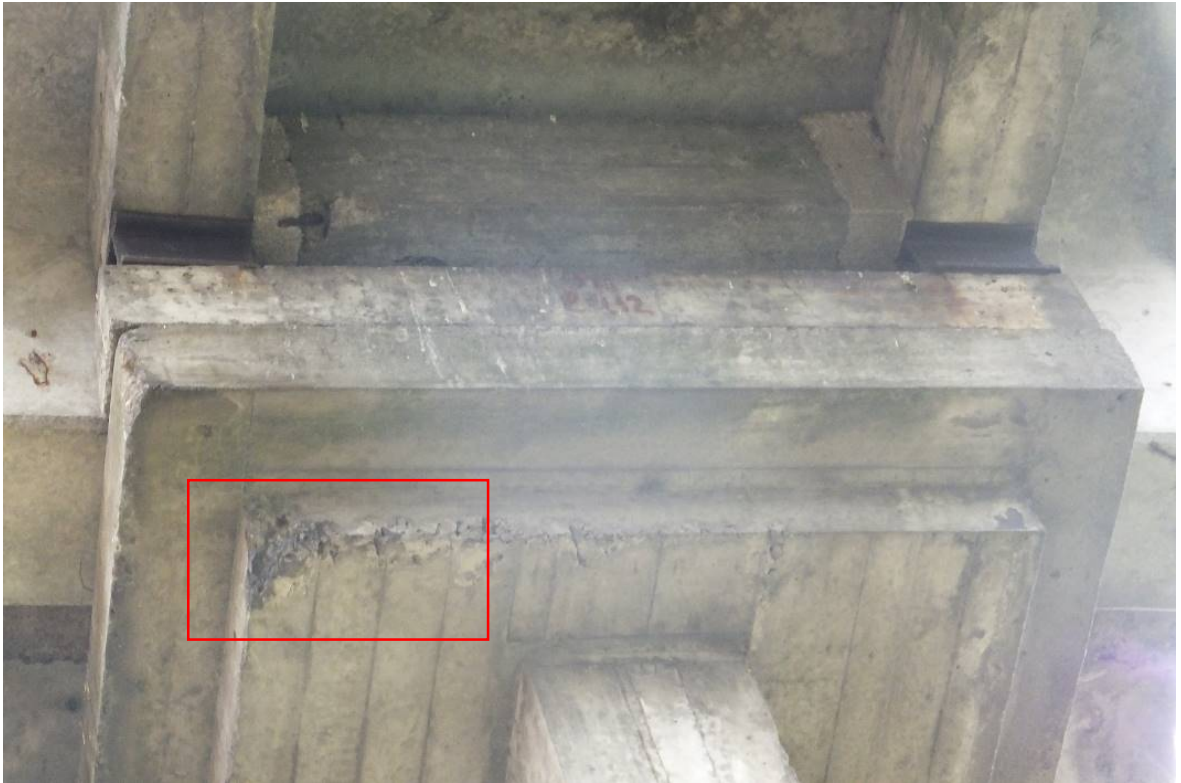
2.11 pav. Nedidelės 5 atramos rygelio pažaidos, vaizdas nuo laiptų pusės
