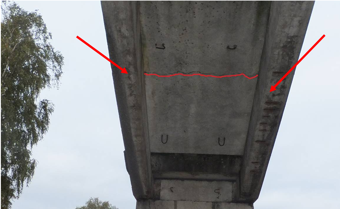
2.15. pav. Antrų laiptų maršo plokštėje skersinis plyšys. Apatinėje maršo laiptasijų dalyje koroduoja laiptasijų armatūra
