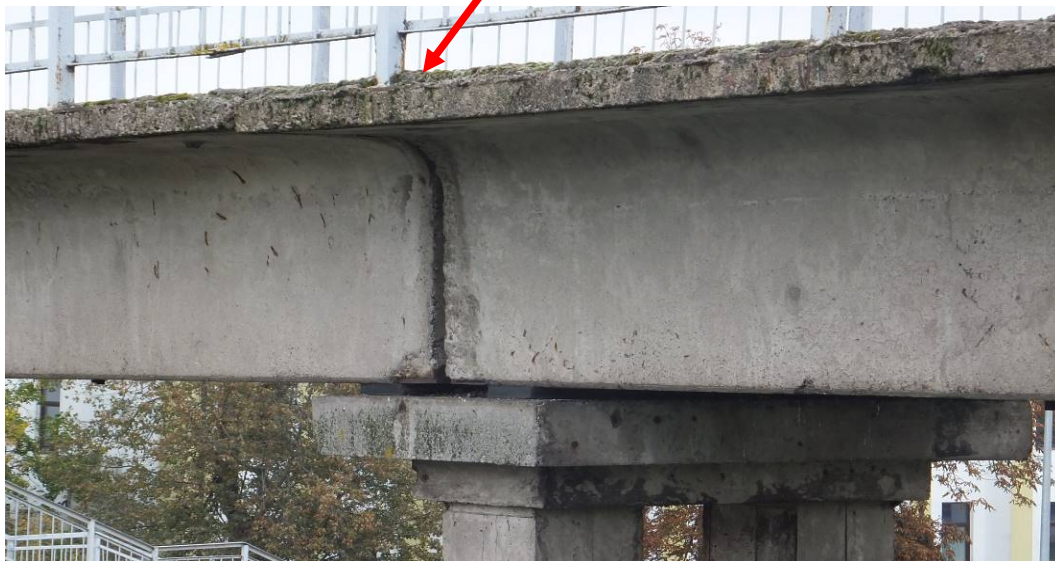
2.4. pav. Vandens tekėjimo žymės ties sijų galais per nesandarų deformacinį pjūvį, vaizdas ties 2 atrama. Einamojoje dalyje deformacinis pjūvis užbetonuotas
