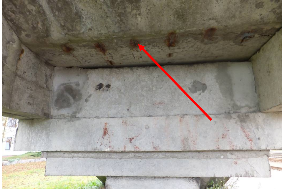
2.13. pav. Pirmų laiptų virš 1-1L atramos, maršo armatūros korozija
