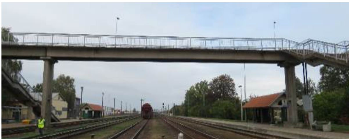
2.31 pav. Pirmojo tarpatramio perdangos bendras vaizdas. Perdangos ilgis – 27,0 m
