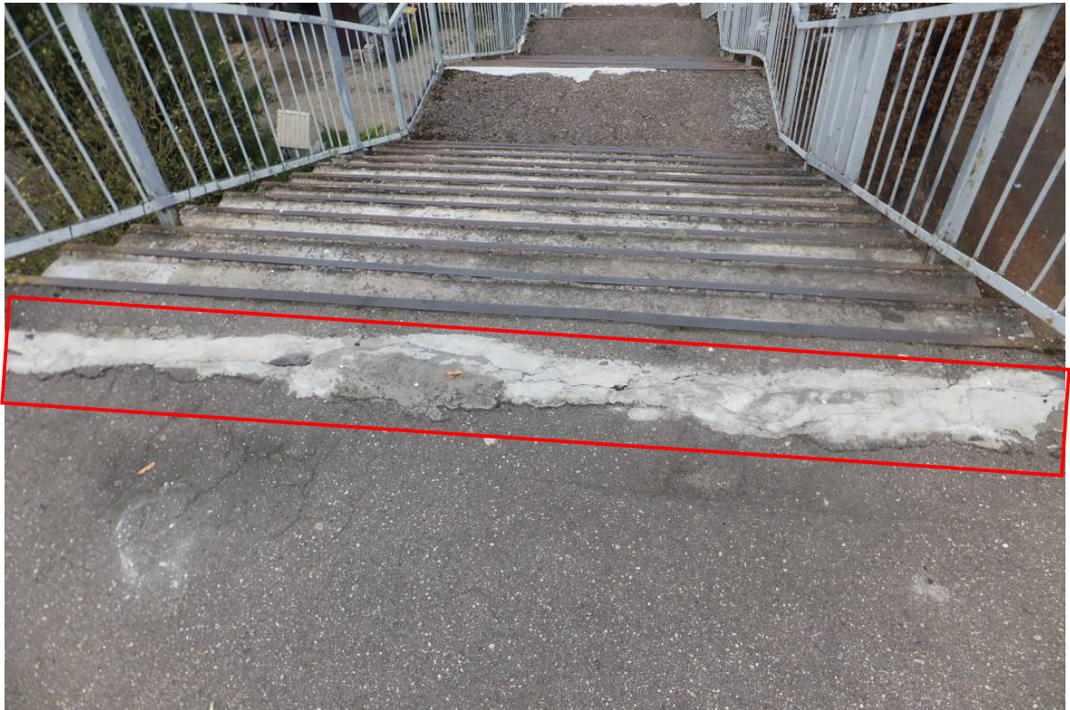
2.21. pav. Laiptų Nr. 4 sujungime su viaduku neįrengta deformacinio pjūvio konstrukcija. Ši konstrukcija neįrengta ties visų laiptų sujungimu. Laiptų pakopas aprėminantis kampuočiai iškilęs aukščiau pakopų paviršiaus, nesaugu.
