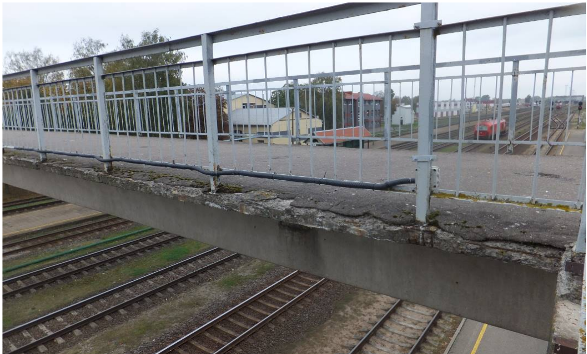
2.6. pav. Perdangos sijų kraštai apirę per visą perdangos ilgį
