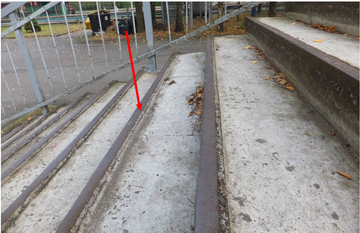
2.20. pav. Trečių laiptų pakopas aprėminantis kampuotis iškilęs aukščiau pakopų paviršiaus, nesaugu, be to, nuo pakopų nenuteka vanduo
