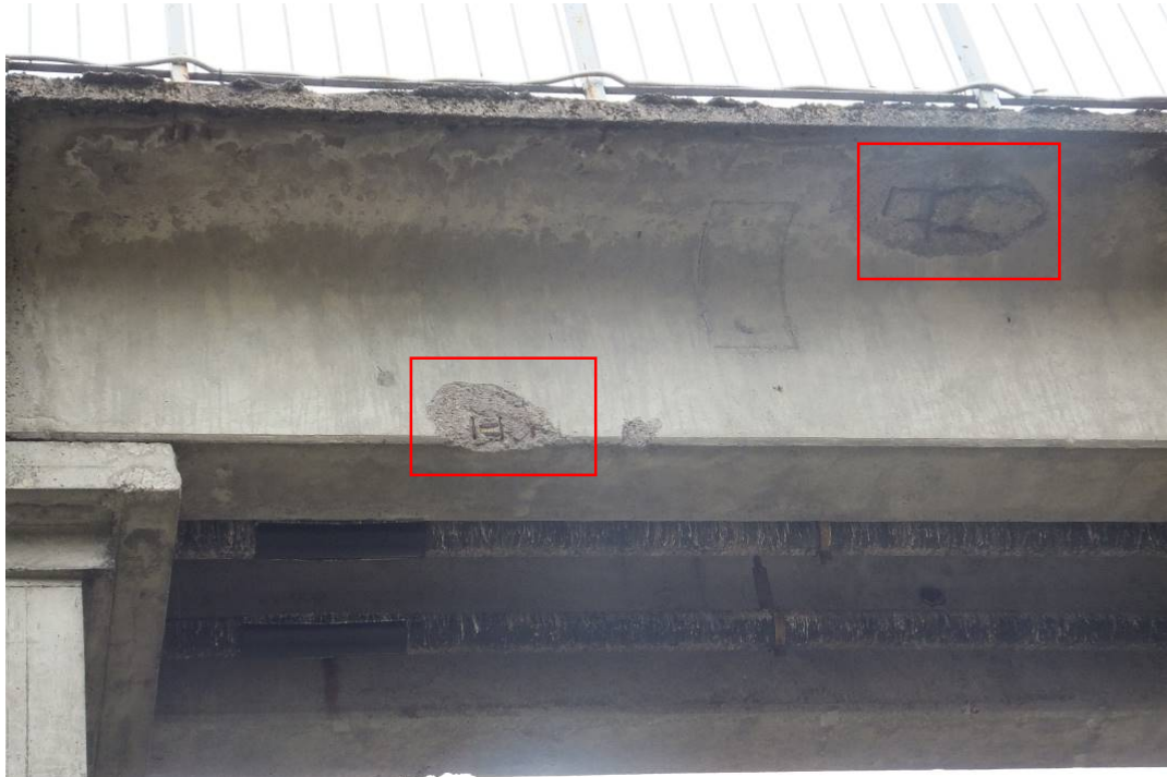
2.7. pav. Antrojo tarpatramio perdangos sijos 2V briaunos mechaninis pažeidimas ir pažaida plokštėje ties trečia atrama
