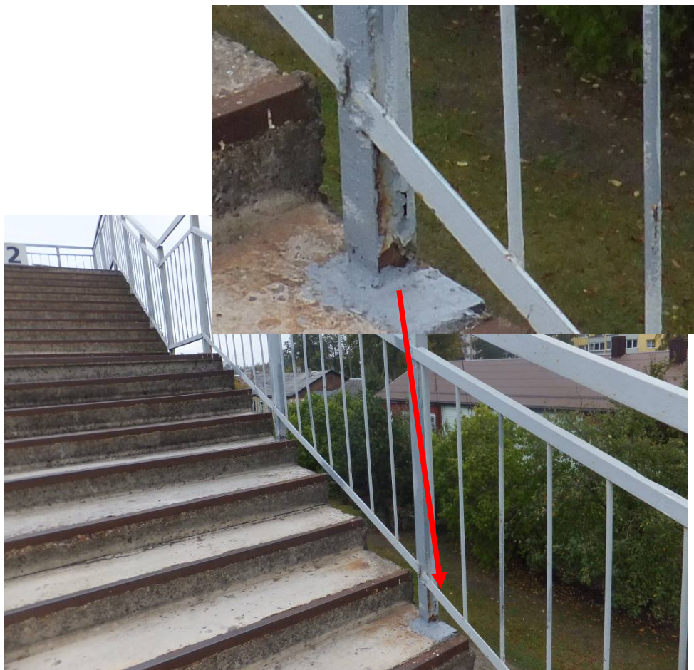
2.14. pav. Pirmų laiptų turėklų elementų korozija. Perdažyta nenuvalius senų dažų
