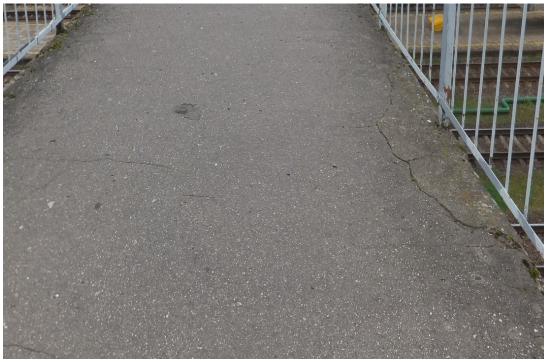
2.1. pav. Asfalto danga supleišėjusi per visą viaduko ilgį, ties perdangos kraštais apirusi, kai kur suremontuota betonu
