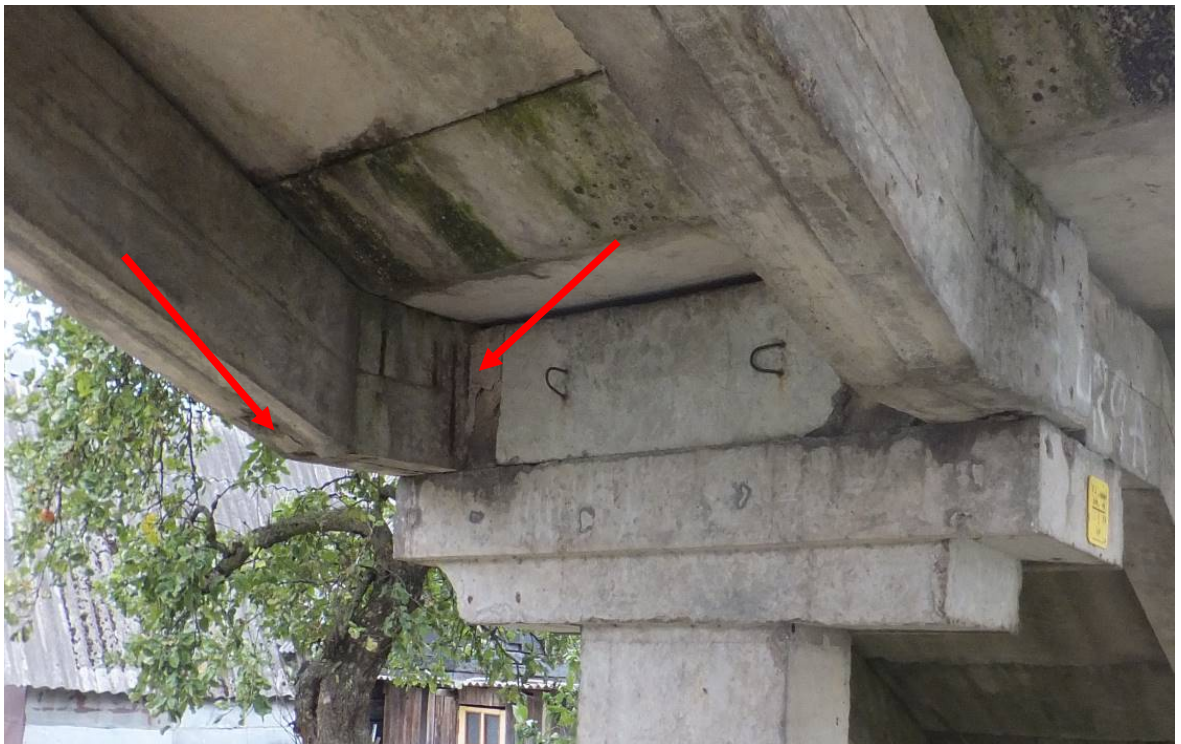
2.22. pav. Ketvirtų laiptų koroduojanti laiptasijas jungiančios skersinės sijos armatūra ties laiptų atrama 4-1L. Laiptasijų armatūra pažeista korozijos
