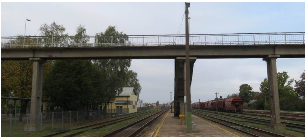
2.33 pav. Antrojo tarpatramio perdangos bendras vaizdas. Perdangos ilgis – 22,0 m
