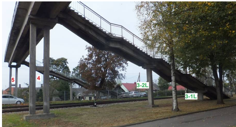
4. pav. Ketvirta ir penkta viaduko atramos ir tretieji laiptai
